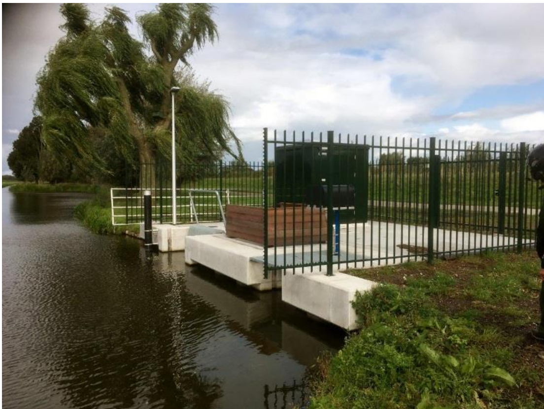
Bouw van het gemaal Noordeind- en Geerpolder in Ter Aar (2023)
