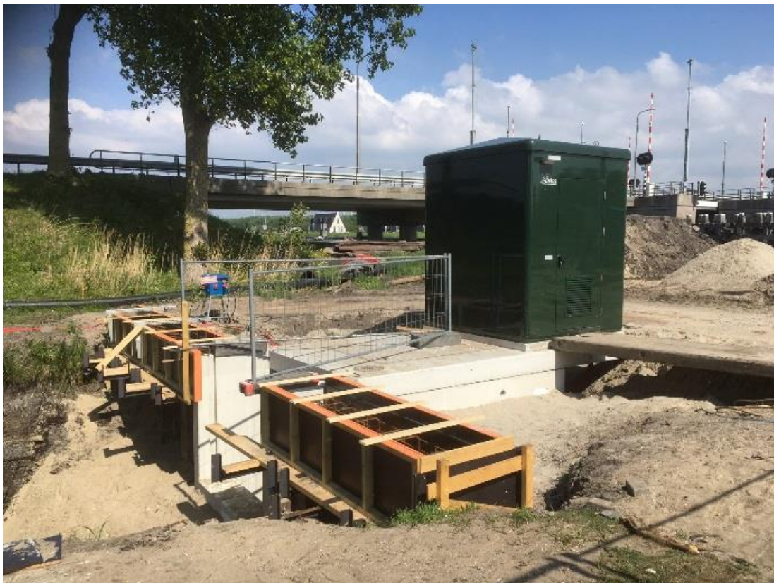
Bouw van het gemaal Elsbroekerpolder in Hillegom (2022)
