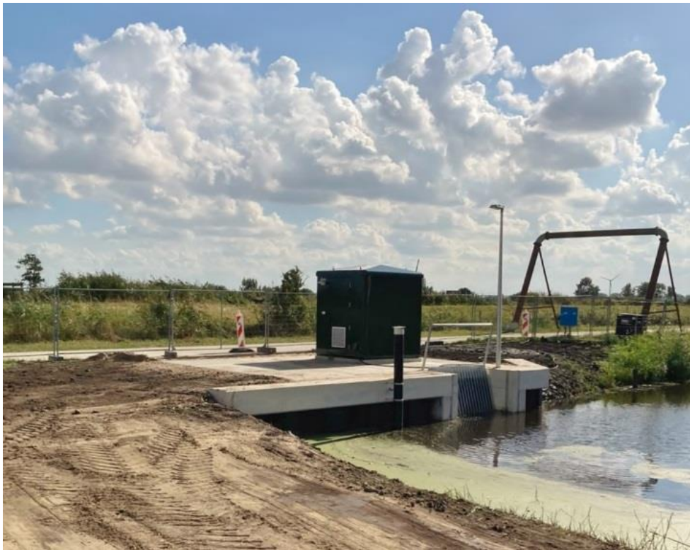
Bouw van het gemaal Bospolder in Leiderdorp, 2022
