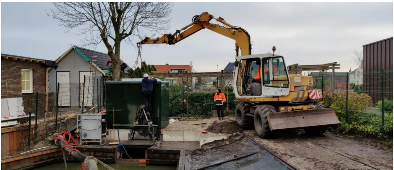
Bouw van het gemaal Meer en Duinpolder aan de Gasstraat in Lisse (2021)
