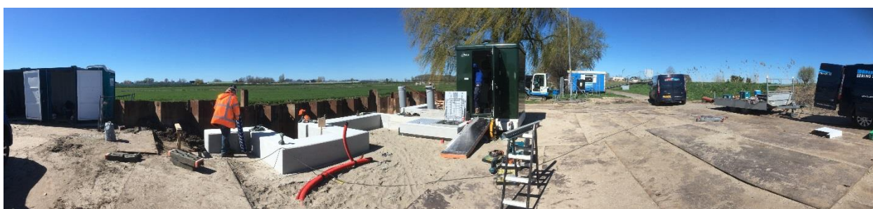
Bouw van het gemaal Noordeind- en Geerpolder in Ter Aar (2023)
